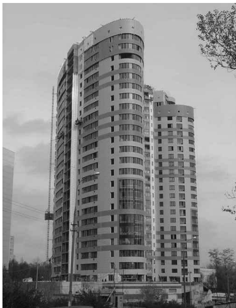
Рис. 2. Жилой комплекс на ул. Давыдовская 19А, вид после окончания строительства
