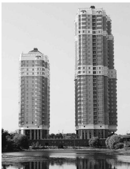
Рис. 1. Жилой комплекс (проспект Вернадского, 37), фото со стороны пруда
