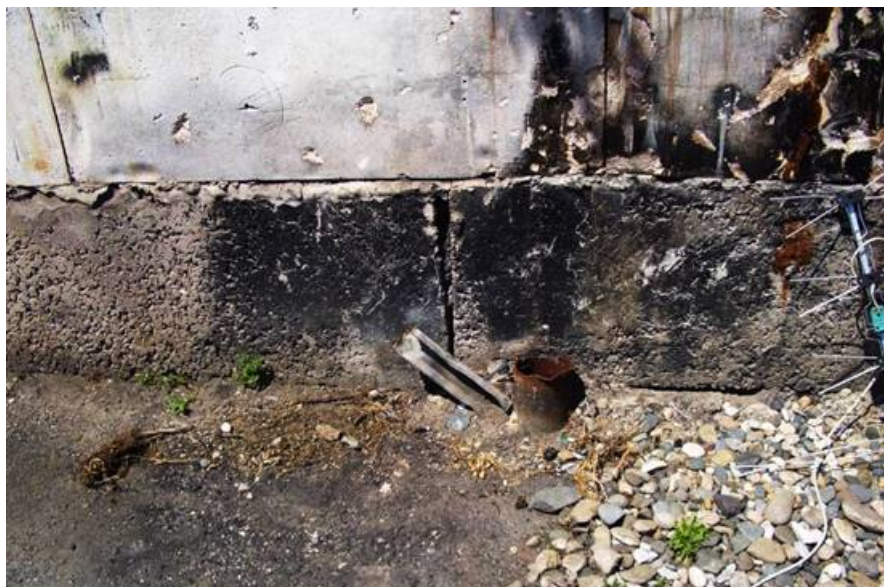
Рис.8 – Фото подземной части колонны навеса у тыльной межи
