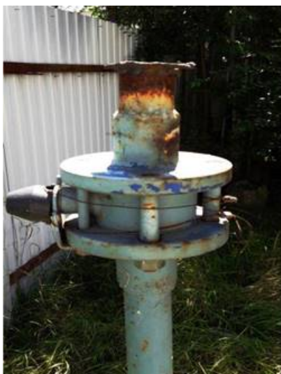
Рис. 17- «Обрезанный» газопровод за тыльной межей у пер. Одесский
