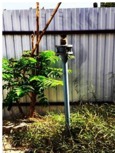
Рис. 17- «Обрезанный» газопровод за тыльной межей у пер. Одесский
