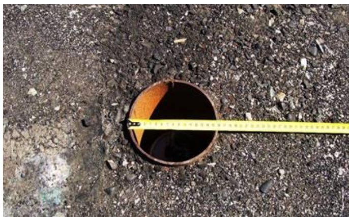
Рис.9 – Подземная часть колонны навеса
