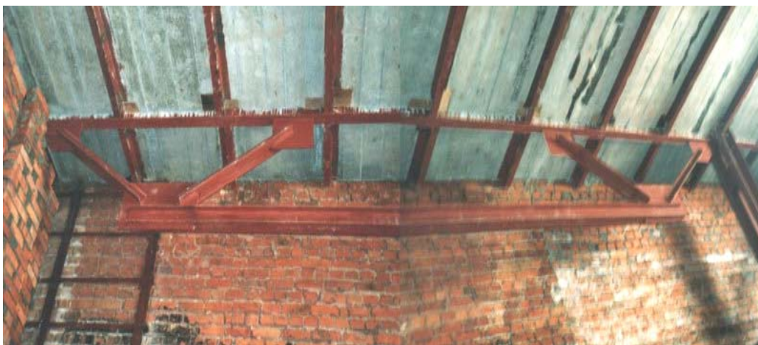
Рис. 9. Балко-ферми перекриття в складі монолітного залізобетонного перекриття
