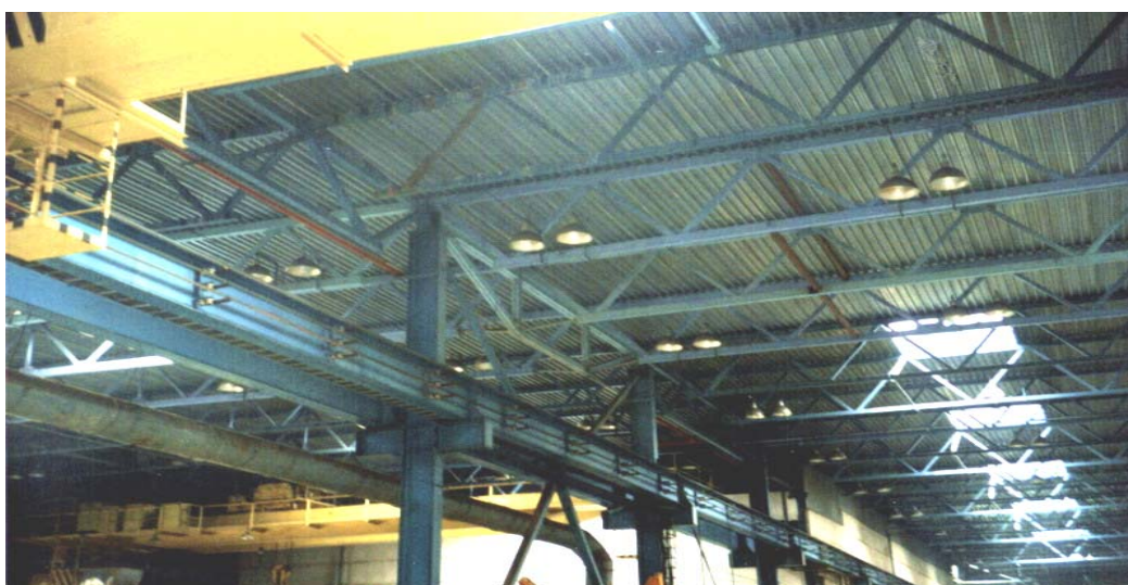
Рис. 7. Підкріп'яна балко-ферма L=12 м. Завод експериментальних механічних випробувань, м. Львів, 2004 р.
