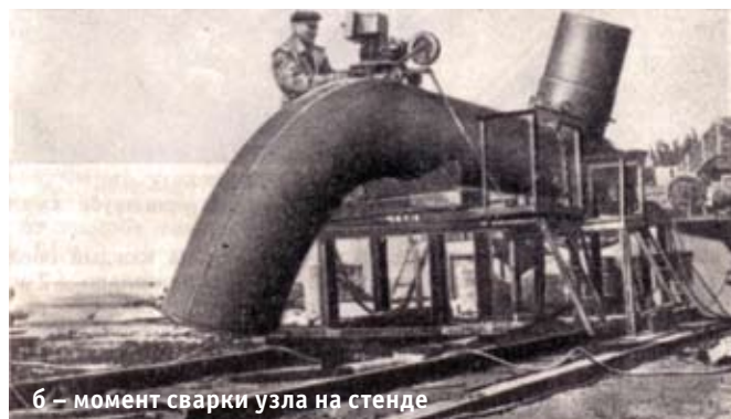
Рис. 1. Стенд для автоматической сварки узлов наружной обвязки центробежных нагнетателей
