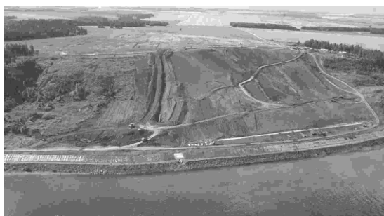
Рис. 1. Фотография перехода магистрального газопровода через р. Кама
