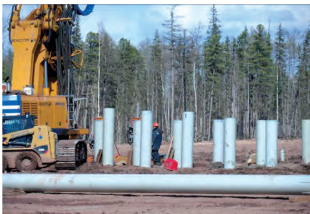
Рис. 1. Монтаж буропускных свай на НПС-2 трубопровода «Куюмба — Тайшет»
