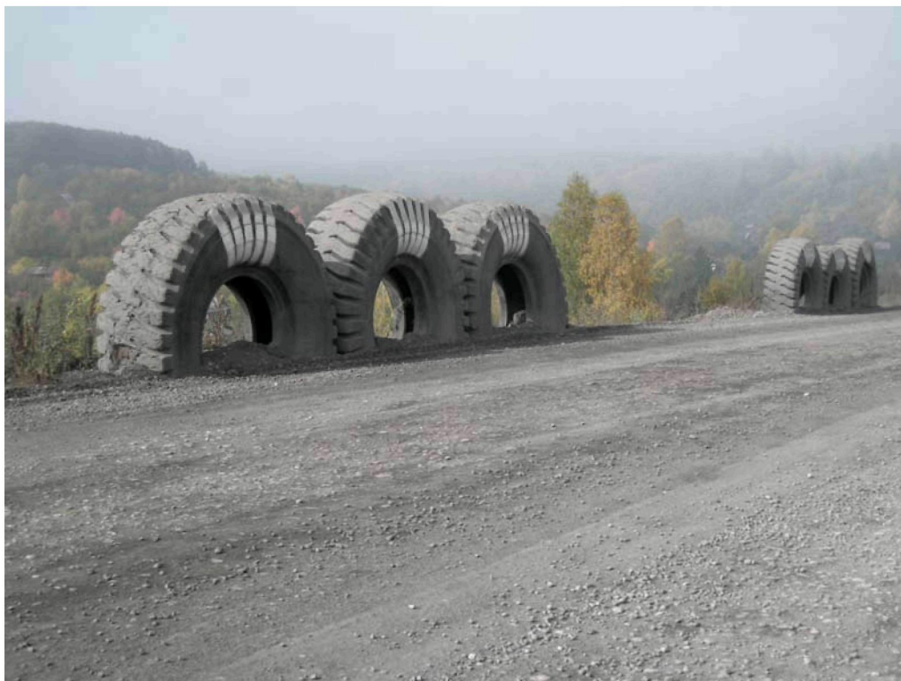
Рис. 5. Схема установки отработанных шин на обочине технологической автодороги
