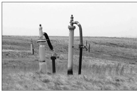
Рис. 4. Дегазационные скважины на закрытых полигонах ТБО США (Landfill Methane Outreach Program, 2006 г.)
