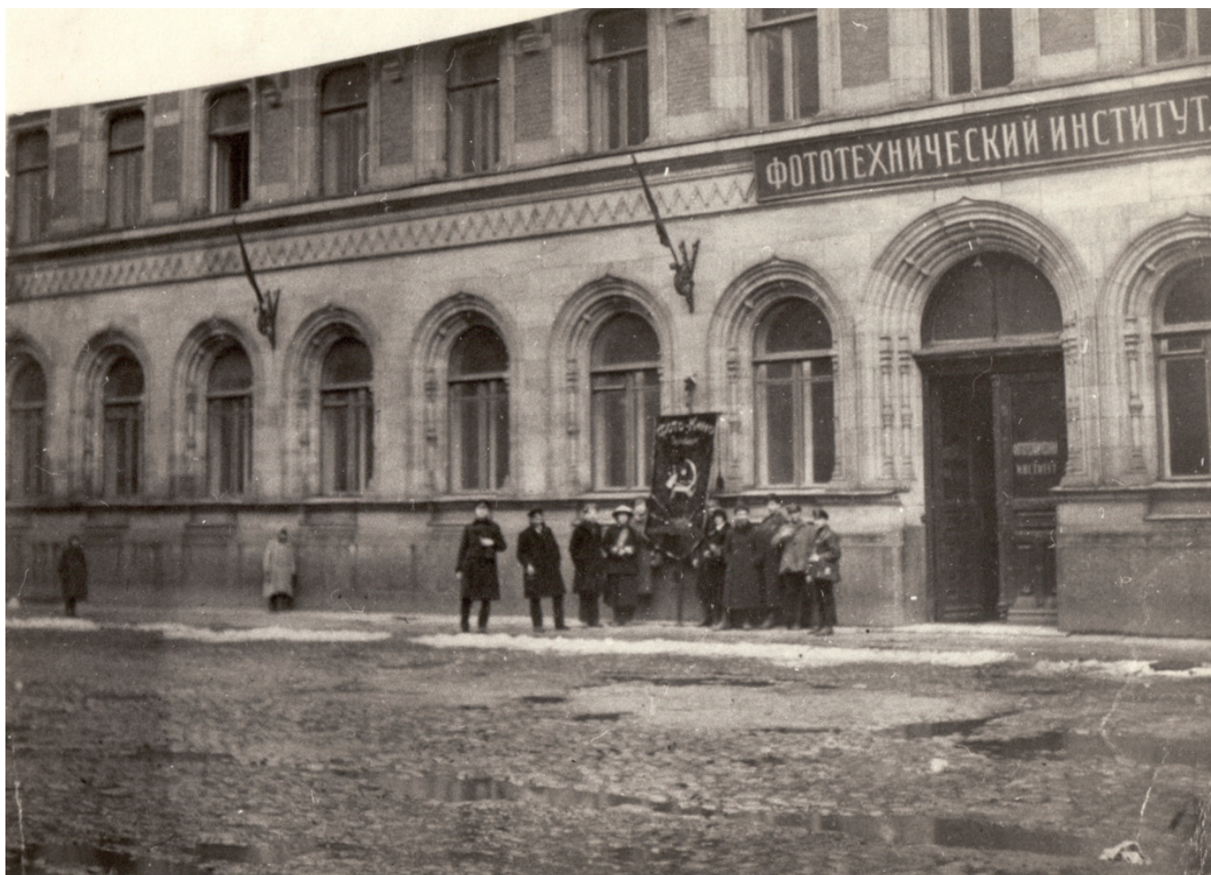
Илл. 1. Неизвестный автор. Здание Петроградского фототехнического института (ул. Правды (Кабинетская), д. 13). 1921–1922 гг. © Архив П.А. Тихонова
