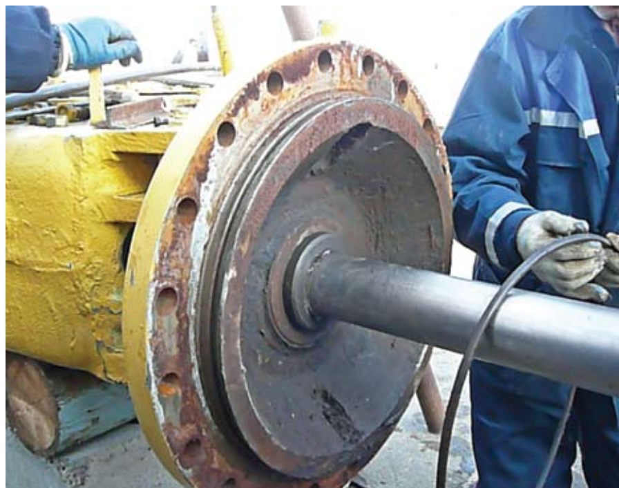
Замена уплотнительных колец на кране МА 39096-1200
