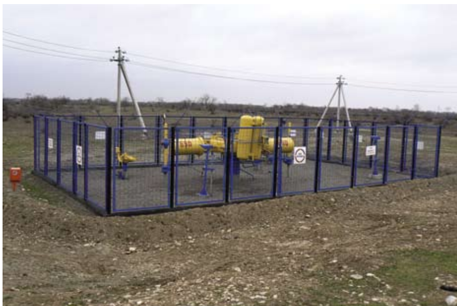
Внешний вид кранового узла после ремонтных работ
