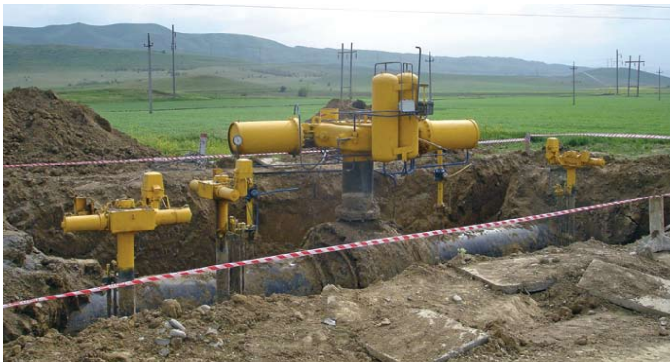
Подготовка КУ к обследованию
