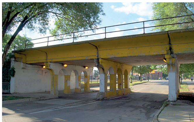
Рис. 12. Современное состояние территории Блумингдейл-Трейл. Виадук
