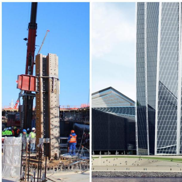
Композитная колонна «Лахта центра» [13]
