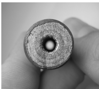
Рис. 2. Отложение солей в трубке бойлера ГВС Fig. 2. The deposition of salts in hot water tube boiler
