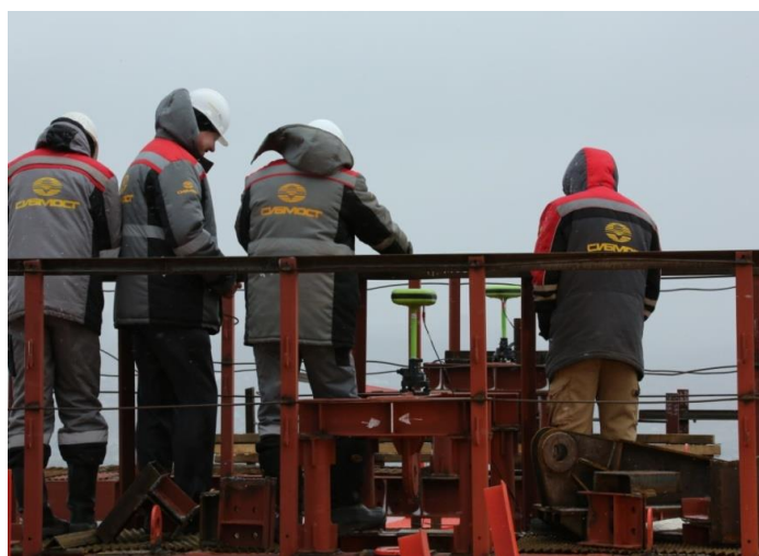
Рис. 2. Установка приёмников ГНСС на двух полусводах арки
