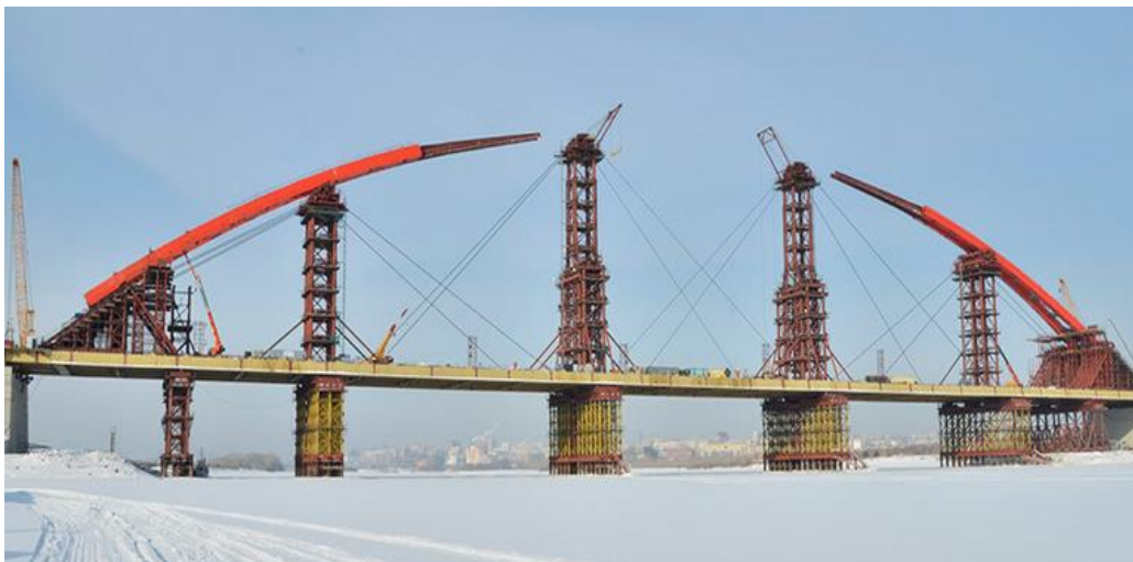
Рис. 1. Надвижка полусводов арки
